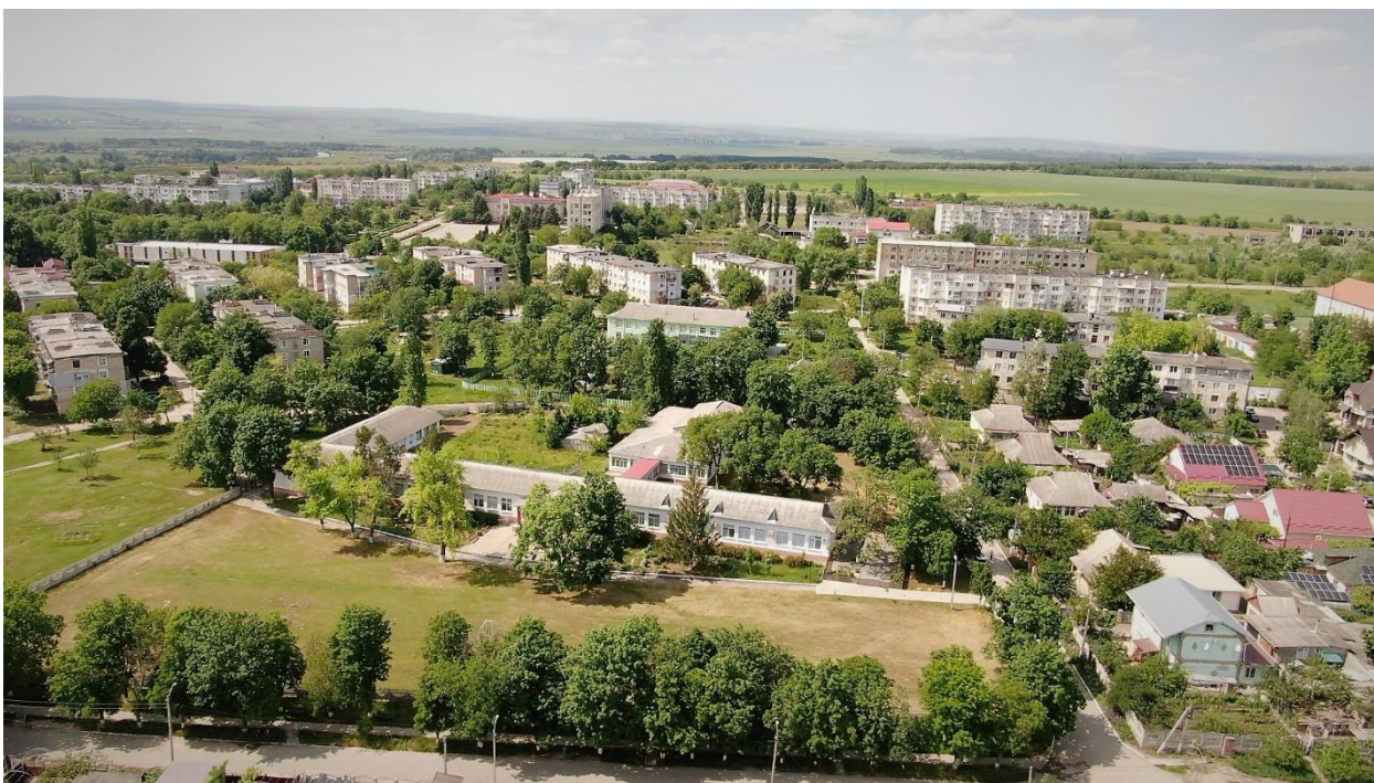
Figura 6 – Blocuri locative și case particulare în orașul Cantemir
